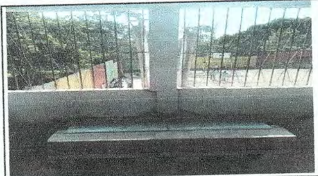
Foto 4: Sustitución de estufa rural (completo).
