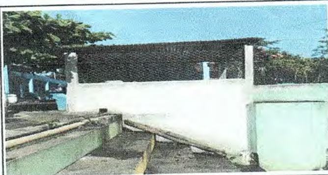
Foto 3: Reparación de muro perimetral, con block y malla.
