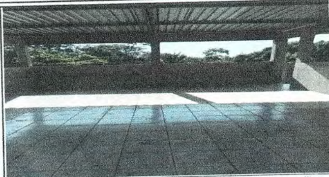
Foto 7: Se sustituyó lámina perforada por lámina troquelada Aluzinc calibre 26 con elementos de fijación.
