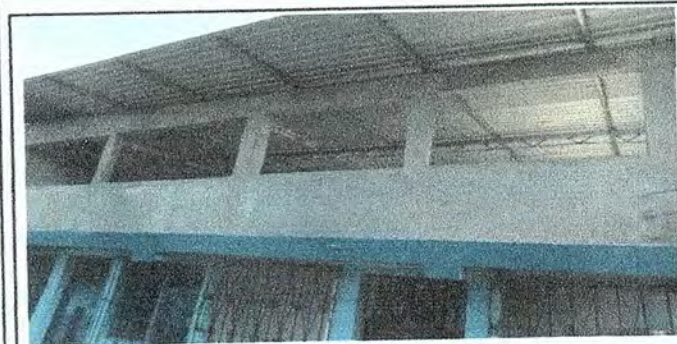
Foto 11: Muro perimetral de block de 32 metros x 1.60 en aula del segundo nivel.
