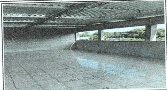
Foto 8: Sustitucion de piso, por piso cerámico.
