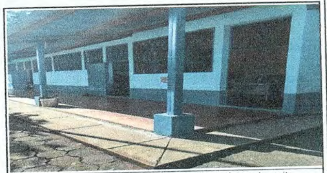
Foto 6: Pintura de exteriores, con pintura acrílica y pintura de aceite.
