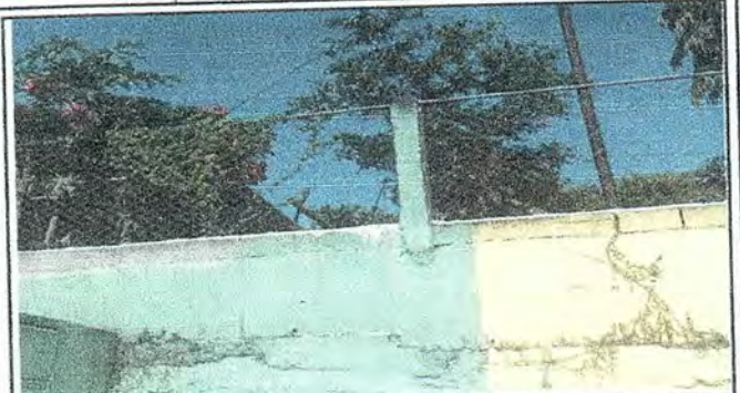
Foto 2: Reparación de muro perimetral, con block y malla.
